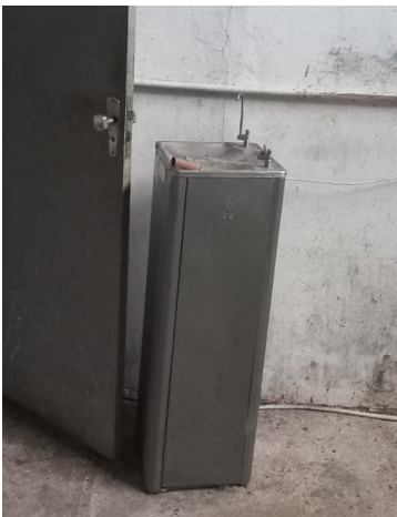
Um bebedouro vertical de chão.
