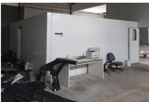
Uma câmara fria, com medidas internas de 7x3m, mais duas salas de 2,50mx2,00m e cerca de 2,20m de altura.
